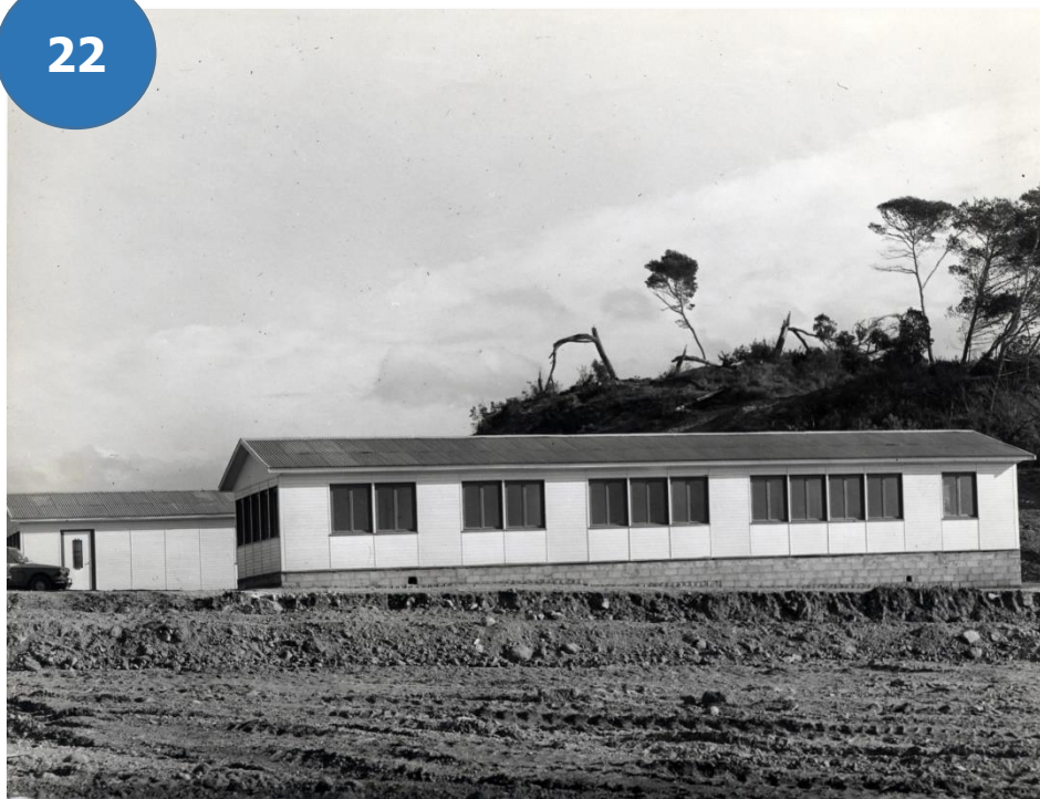
Exemple de baraquement en préfabriqué projeté pour la cité des Ajoncs à Saint-Avé. [1963].
